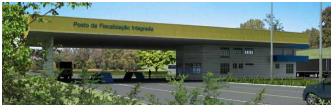
Figura 13. Passagem Modelo de Pórtico de Fiscalização em processo de licitação
